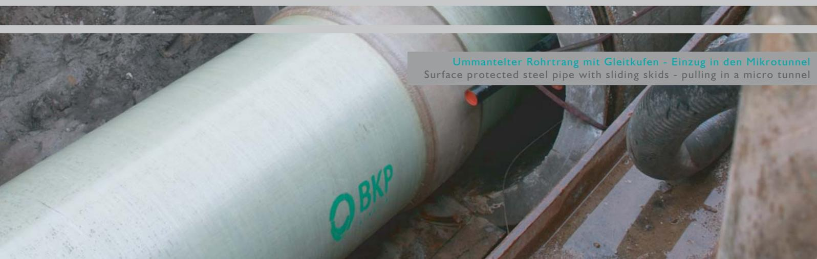
Ummantelter Rohrtragn mit Gleitkufen - Einzug in den Mikrotunnel
