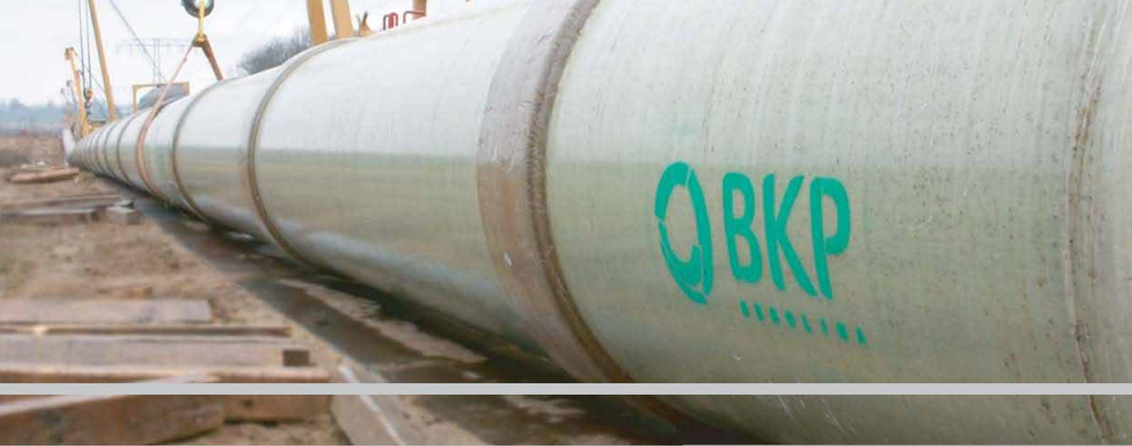
DN 1.400 Stahlrohr GFK ummantelt mit Gleitkufen
