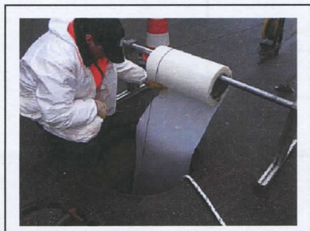
Figure 4.1 : Insertion du préliner
