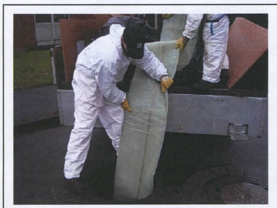
Figure 4.3 : Traction de la chemise
