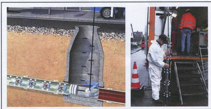
Figure 4.4 : Mise en œuvre du train de lampes
