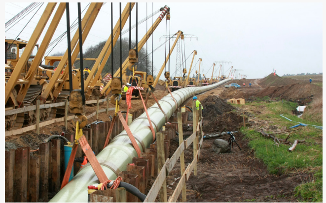
DN 1.400 GFK-Ummantelung + GFK-Gleitkufen
