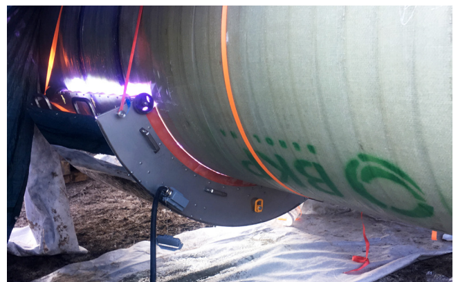
Neue UV-Technik für Schweißnahtnachumhüllung, 2019
