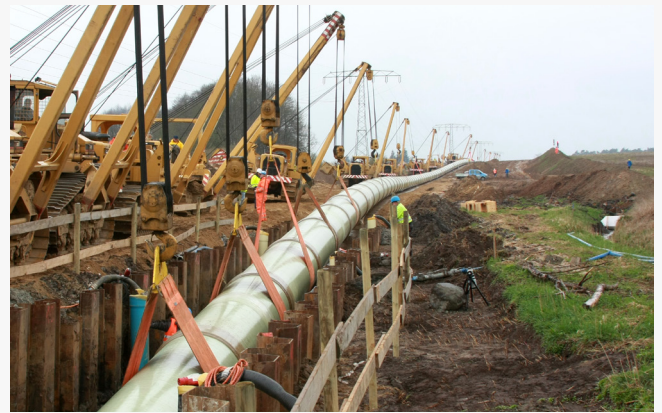
DN 1.400 GFK-Ummantelung + GFK-Gleitkufen
