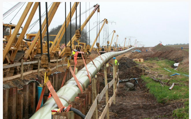
DN 1 400 GAP-skyddsmantel + GAP-glidskor
