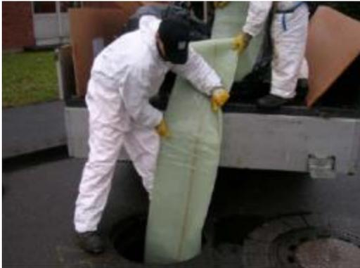
**Figure 4.3 : Traction de la chemise**
