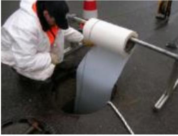
**Figure 4.1 : Insertion du préliner**
